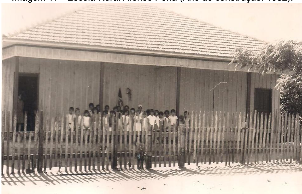
Imagem 17 - Escola Rural Afonso Pena (Ano de construção: 1962).
